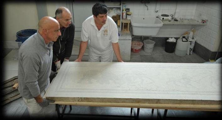
Intervento eseguito sul retro del pannello per il risanamento della malta di supporto delle tessere musive, con asportazione del travertino.
