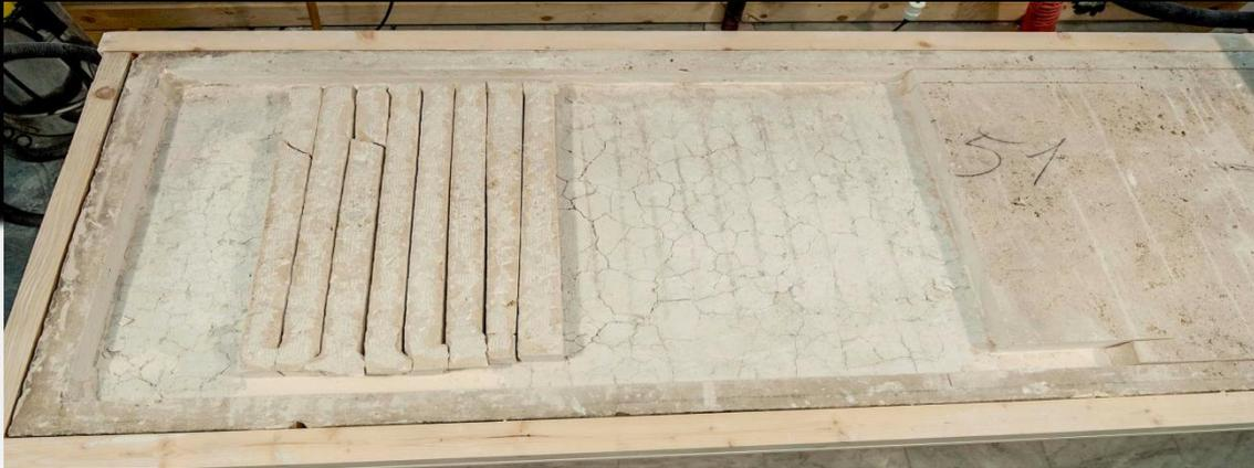
Rimozione del travertino dal retro del pannello mediante tagli trasversali.
